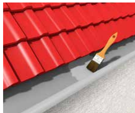
Ereszcsatornák szigetelése és javítása
