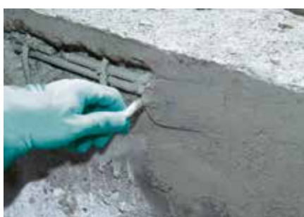
4 Javítóhabarcs bedolgozása
