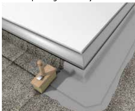
Tetőn átfedések szigetelése és lezárása
