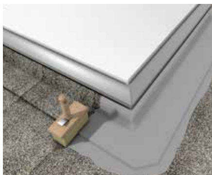
Tetőn átfedések szigetelése és lezárása
