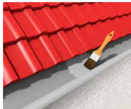
Ereszcatornák szigetelése és javítása
