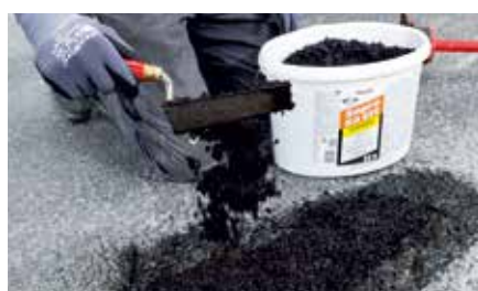
2 Sopro KaltAsphalt felhordása
