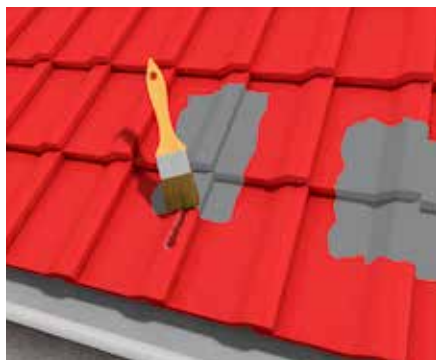
Tetőcserepek szigetelése és javítása
