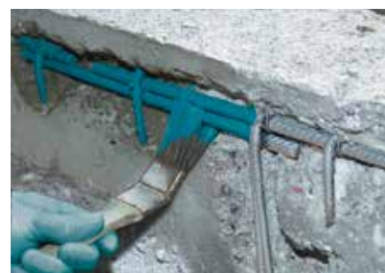
2 Korrozióvédelem
