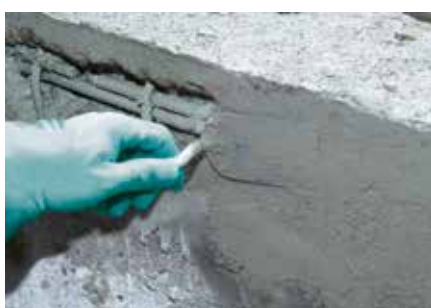
4 Javítóhabarcs bedolgozása
