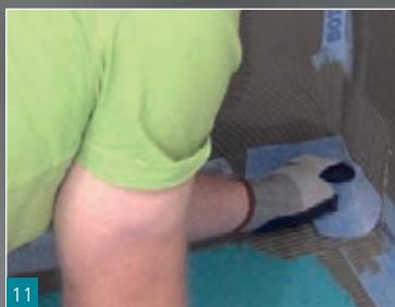
11 Botament® SB sarokelem elhelyezése a Botament zuhanytálcához
