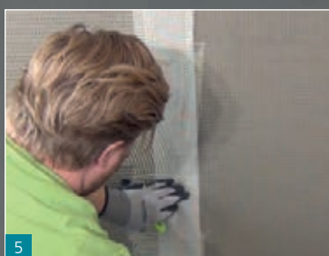
5 Üvegháló felhelyezése
