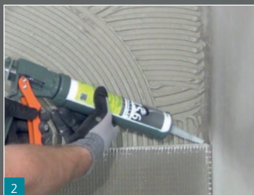
2 BP építőlemezek illesztése Botament® MS 6-tal (Megjegyzés: kerülni kell a keresztkötések)
