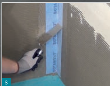
8 A Botament® SB 78 szaniter szalag beágyazása a friss szigetelésbe
