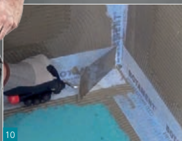
10 Botament® SB sarokelem előkészítése a Botament zuhanytálcához
