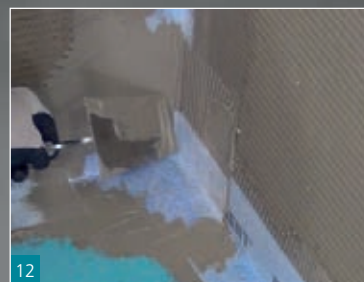
12 Botament® SB sarokelem besimítása a Botament zuhanytálcához
