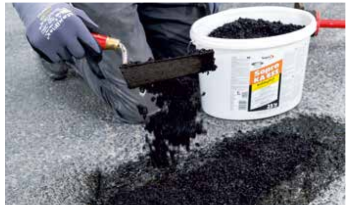
2 Sopro KaltAsphalt felhordása
