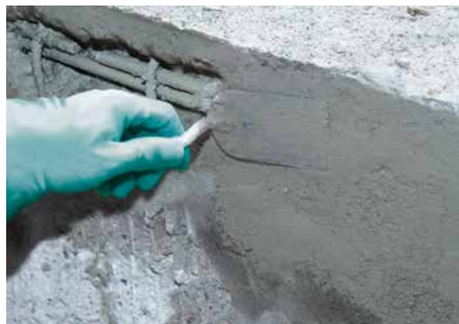
4. Javítóhabarcs bedolgozása Repadur 50-nel
