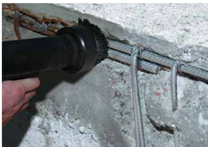
1. Aljzatelőkészítés homokszórással
