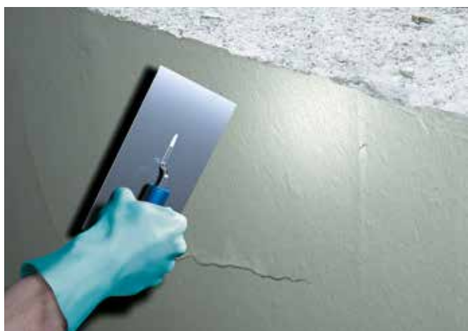
5. Felület lezárása Repadur 5-tel
