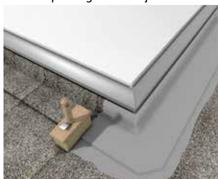
Tetőn átfedések szigetelése és lezárása
