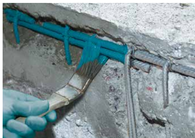
2. Korrózióvédelem Repadur KS-sel
