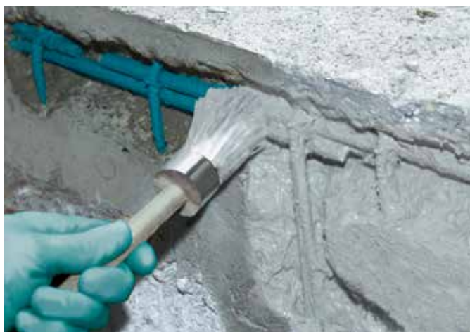
3. Tapadóhíd felvitele Repadur MH-val
