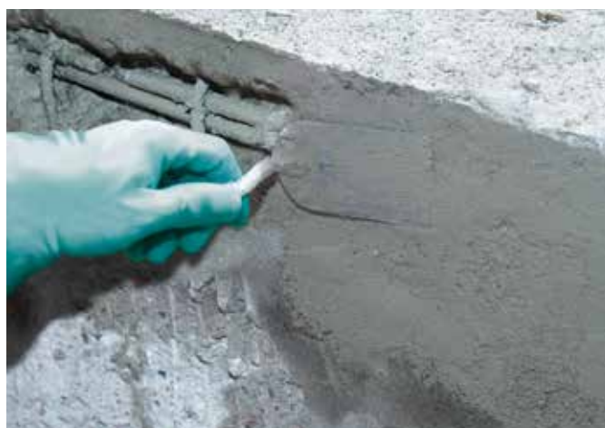
4. Javítóhabarcs bedolgozása Repadur 50-nel
