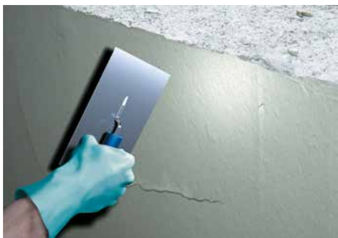
5. Felület lezárása Repadur 5-tel
