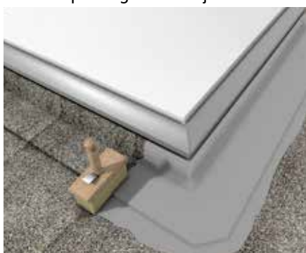
Tetőn átfedések szigetelése és lezárása
