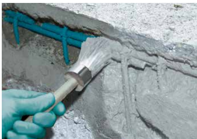
3. Tapadóhíd felvitele Repadur MH-val
