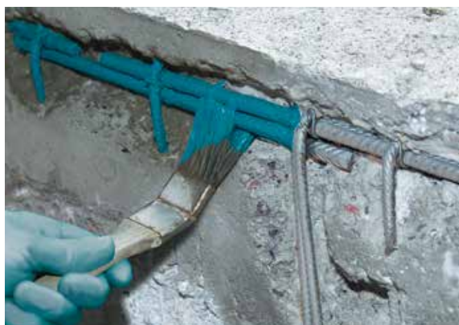
2. Korrózióvédelem Repadur KS-sel
